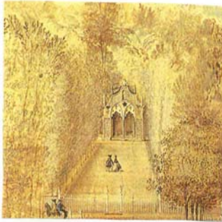
Abb. 161 Farmgebäude mit vorgeblendeter gotischer Fassade, Davenport House
