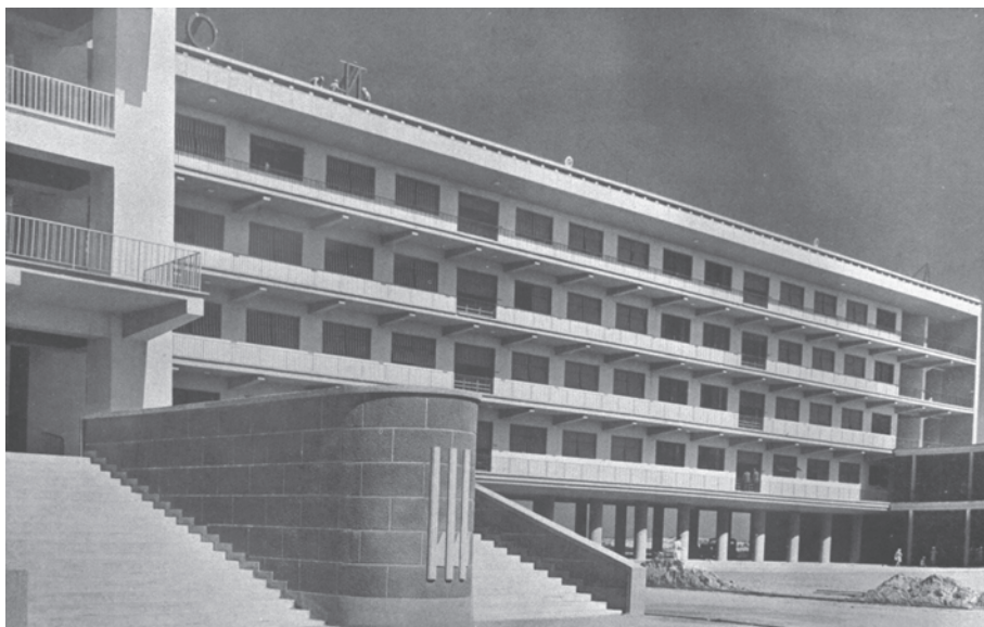
Abb.222 Ferienkolonie „Montecatini“: Rednerkanzel nebst Treppenanlagen in den Rampenturm [Montecatini 1939, S.20]
