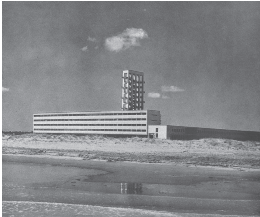
Abb.233 Ferienkolonie „Montecatini“: Ansicht der Strandseite während der Bauausführung, der rückwärtige Flügel fehlt noch [Montecatini 1939, S.12]
