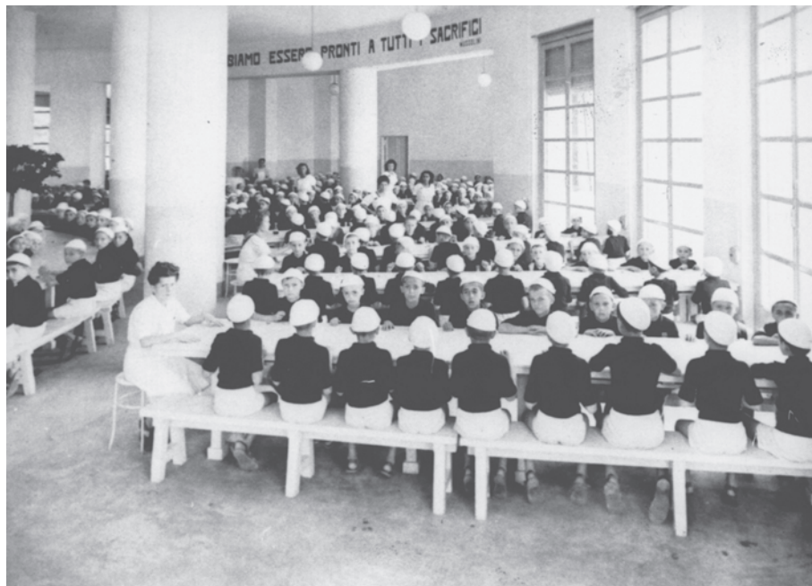
Abb.60 Fiat-Ferienkolonie „Torre Balilla“: Speisesaal im Erdgeschoss des Turmbaus [ASF 118 AT P2]
