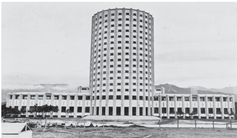
Abb.58 Fiat-Ferienkolonie „Torre Balilla“: Haupteingang mit Freitreppe [Architettura 1933, S.634]
