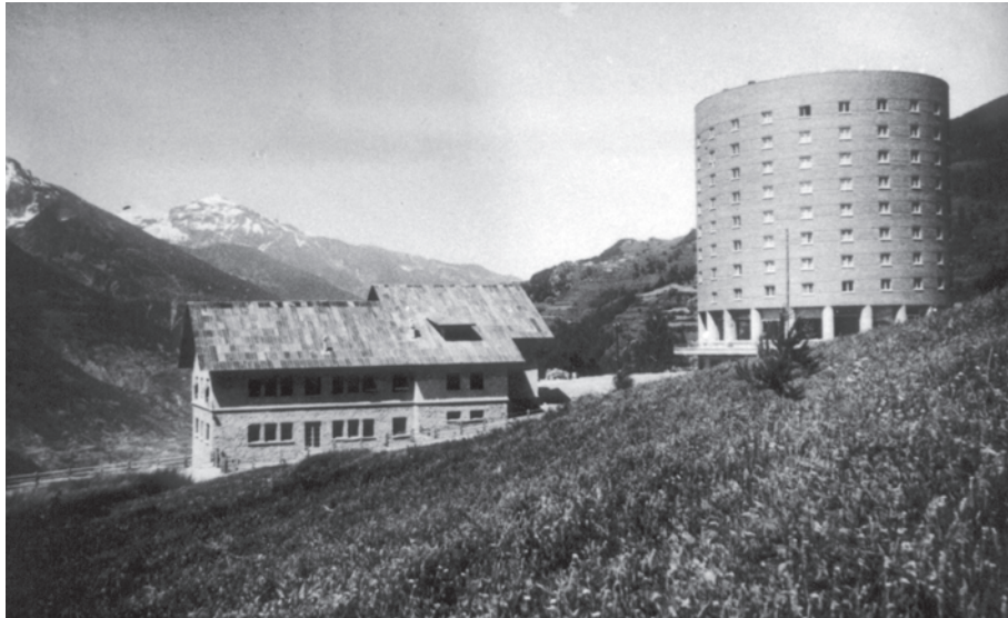
Abb.79 Fiat-Ferienkolonie „Tina Nasi Agnelli“: westliches Nebengebäude [ASF 114 AT P1]
