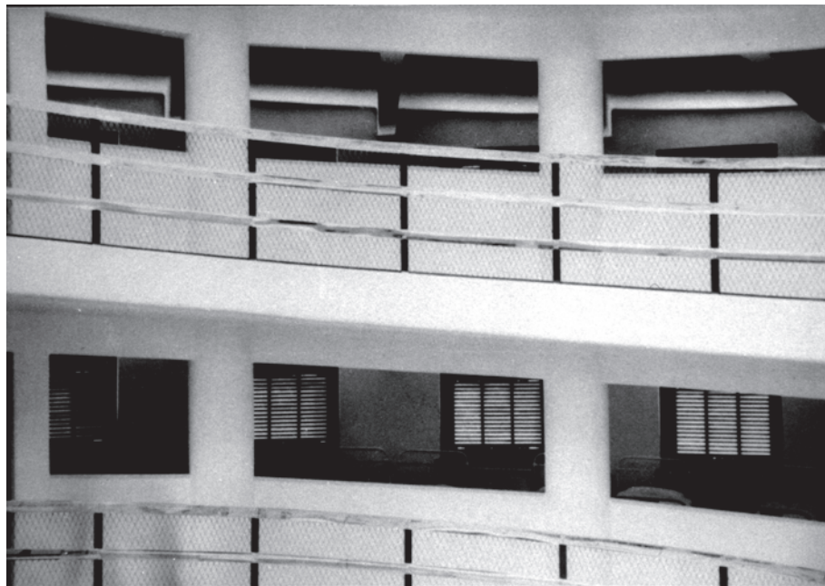
Abb.65 Fiat-Ferienkolonie „Torre Balilla“: Halbwand zwischen Schlafsälen und Rampenweg [ASF 118 AT P2]
