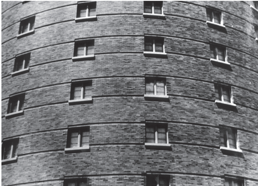
Abb.87 Fiat-Ferienkolonie „Tina Nasi Agnelli“: Fassade [ASF 114 AT P1]
