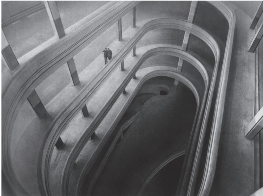
Abb.114 Fiat-Automobilfabrik „Lingotto“: Spiralrampe auf der Südseite (1926) [Olmo 1994, Abb.11]
