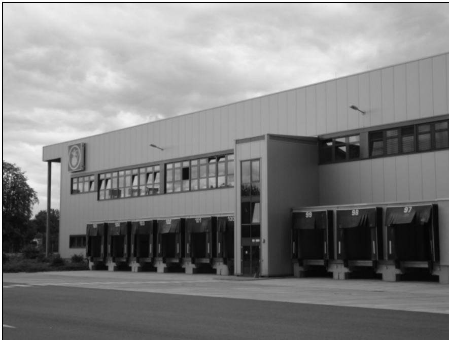
Abbildung 5-13 Gebäude mit Andocktoren (eigenes Foto)
