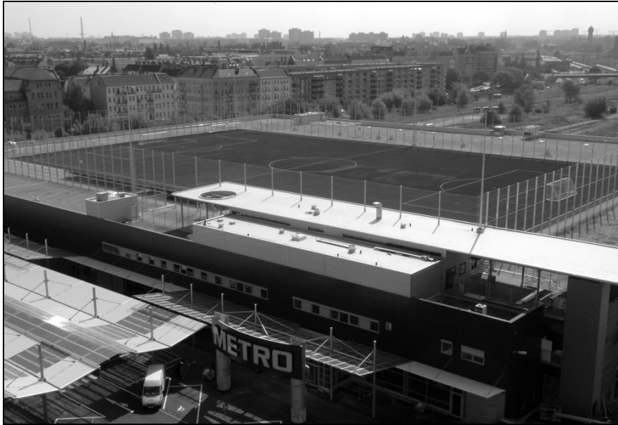
Abbildung 5-27 Sportplatz auf dem Dach des METRO Cash & Carry-Marktes in Berlin-Friedrichshain (METRO Cash & Carry Deutschland o.J.)
