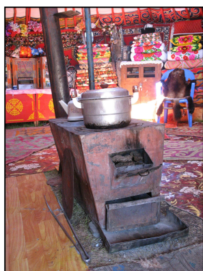
Abb. 25: Ofen aus Eisenblech
