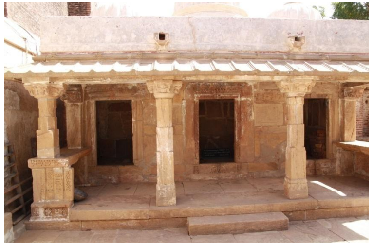
Abb. 119: Delmal, Limbojīmātā-Tempel, Westseite des nordöstlichen Nebentempels
