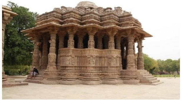
Abb. 93: Moḍhera, nṛtya-maṇḍapa von Südwesten
