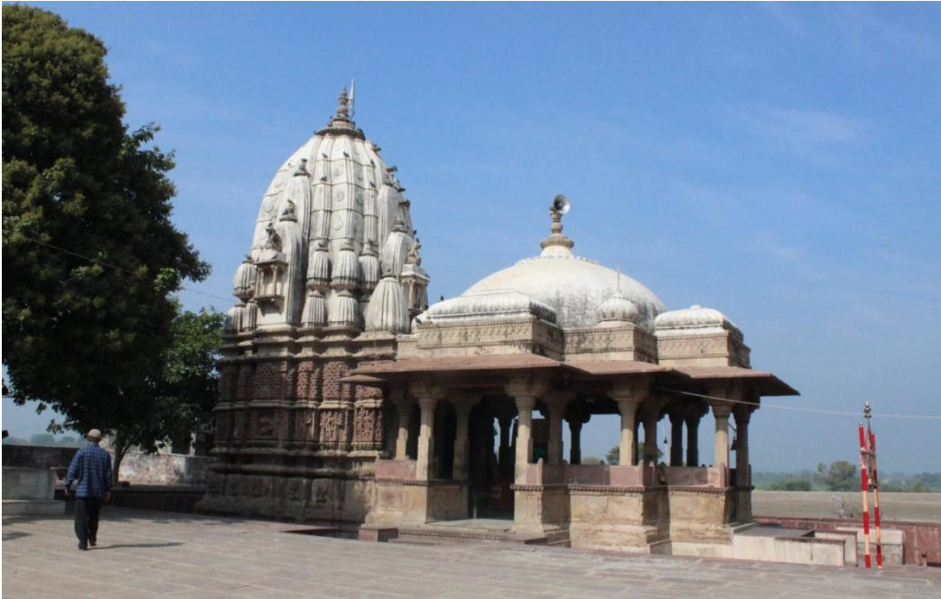
Abb. 297: Buḍhādīt, Sūrya-Tempel von Südosten.
