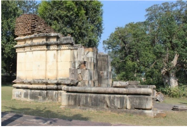
Abb. 269: Bārolī, Tempel 1 von Südosten
