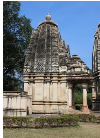
Abb. 273: Bārolī, Tempel 5 und 6 von Süden
