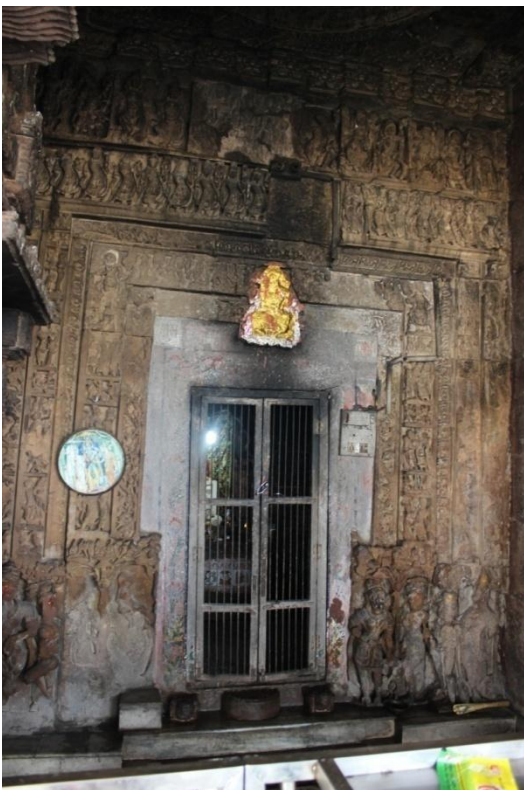
Abb. 298: Buḍhādīt, Sūrya-Tempel, dvāra des garbhagrha .
