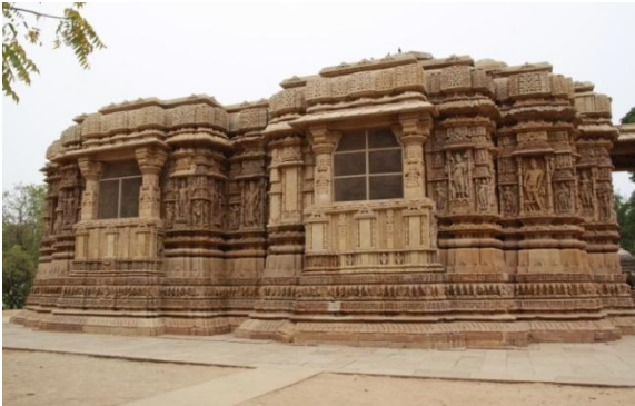
Abb. 94: Moḍhera, Sūrya-Tempel von Süden
