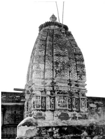
Abb. 185: Pāranagar, Nīlakaṅṭha-Tempel von Osten (AIIS 63590)
