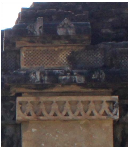
Abb. 286: Bārolī, Tempel 1, obere Wandprofilierung
