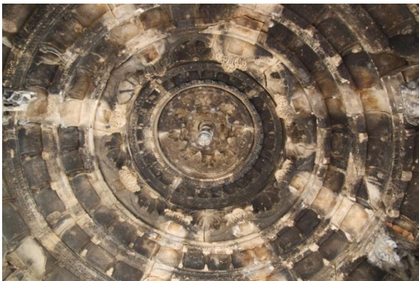
Abb. 174: Nagda, Bahū-Tempel, Decke des maṇḍapa
