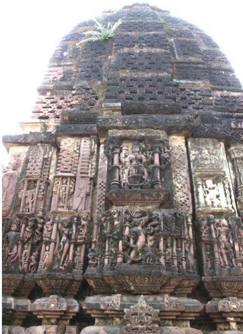
Abb. 323: Atru, Śyāma-Sundara-Tempel, Nordseite
