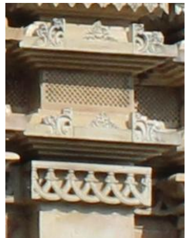
Abb. 287: Bārolī, Tempel 7, obere Wandprofilierung
