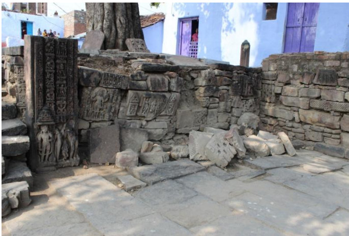
Abb. 328: Atru, Umfassungsmauer des Śyāma-Sundara-Tempels
