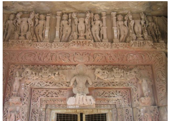
Abb. 352: Gyāraspur, Bājṛāmaṭh-Tempel, dvāra des Sūrya-Tempels (Foto: S. Saxena)
