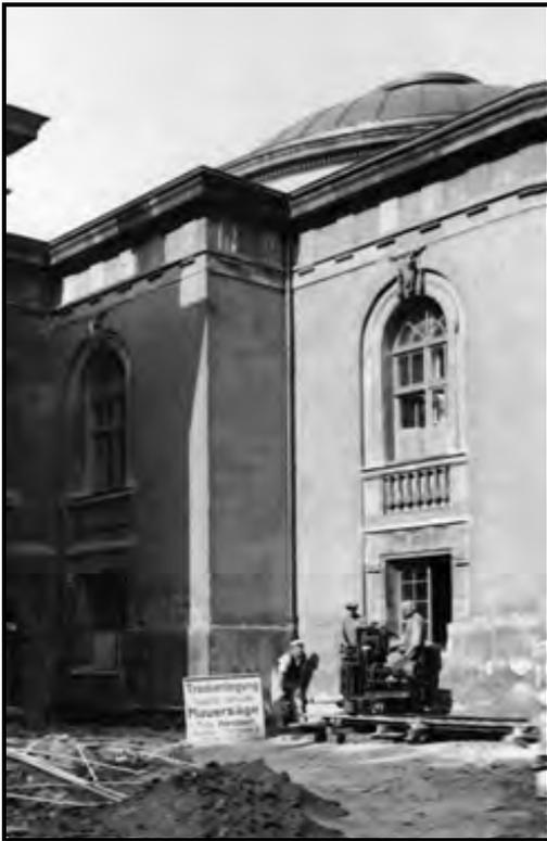
Abbildung 31: Trockenlegungsarbeiten am Institut für Lebensmittelhygiene
