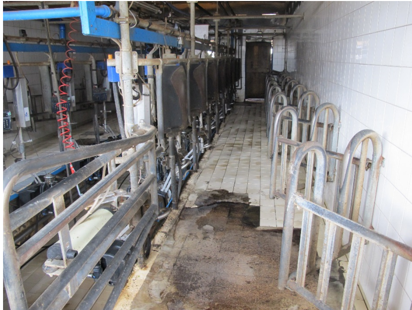
Abbildung 51: Baufälliger Doppel-8er Fischgrätenmelkstand
