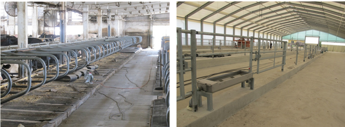
Abbildung 91: Neu verlegter Spaltenboden sowie neu gebauter Jungviehstall
