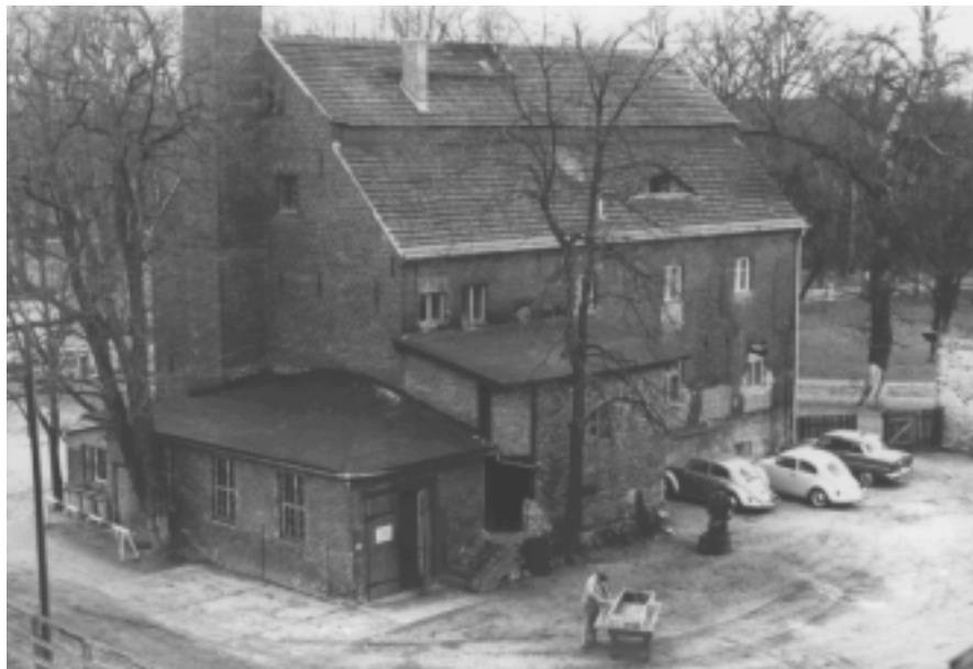
Abb. 31 Brennerei mit Schmiedeanbau, um 1960
