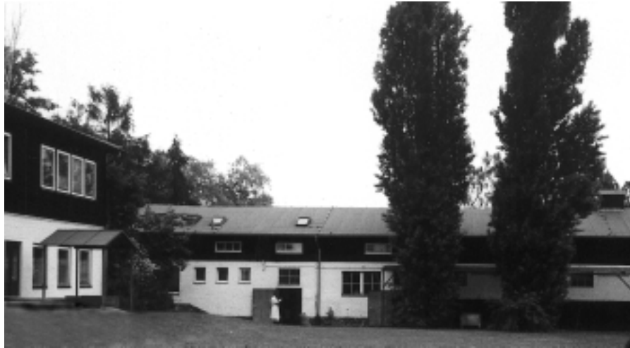
Abb. 18 Klautierklinik, Stall- und Hörsaalgebäude, 2001
