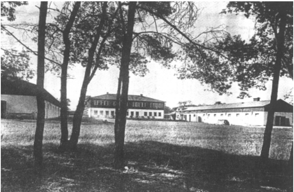
Abb. 17 Reichsreiterführerschule aus südlicher Richtung, um 1940
