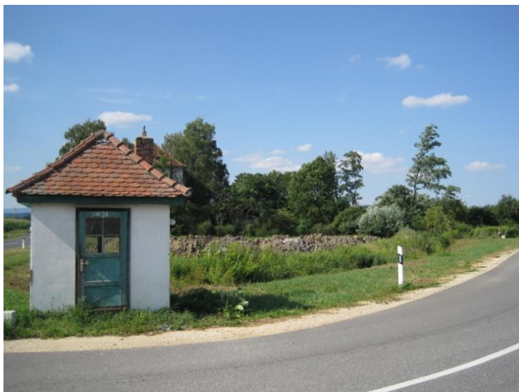
Figure 113 : BL 7 - ancien poste frontalier
