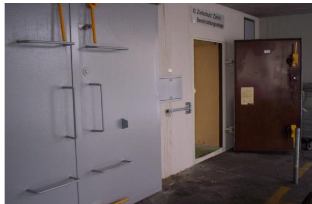
Figure 50 : RZ 12 - abri anti-aérien, sous le terrain
