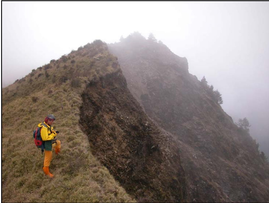
Photo 41 Talschluss des Chenyulan Valley nördlich von Batongguan (s. Abb. 5, 32 und 33). Das Tal weist bis in seinen Talschluss in 3.850 m Spuren rückschreitender Erosion durch den Chenyulan Xi auf. Die von frischen Abbrüchen gesäumten Talflanken sind vollständig frei von Vegetation. Aufnahme: 29.03.2002; 3.850 m; Blickrichtung: W
