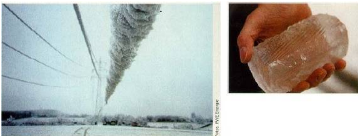
links: Eisbehang eines abgerissenen Freileitungsseiles rechts: Eisklumpen mit Seilabdruck (Quelle: RWE AG)
