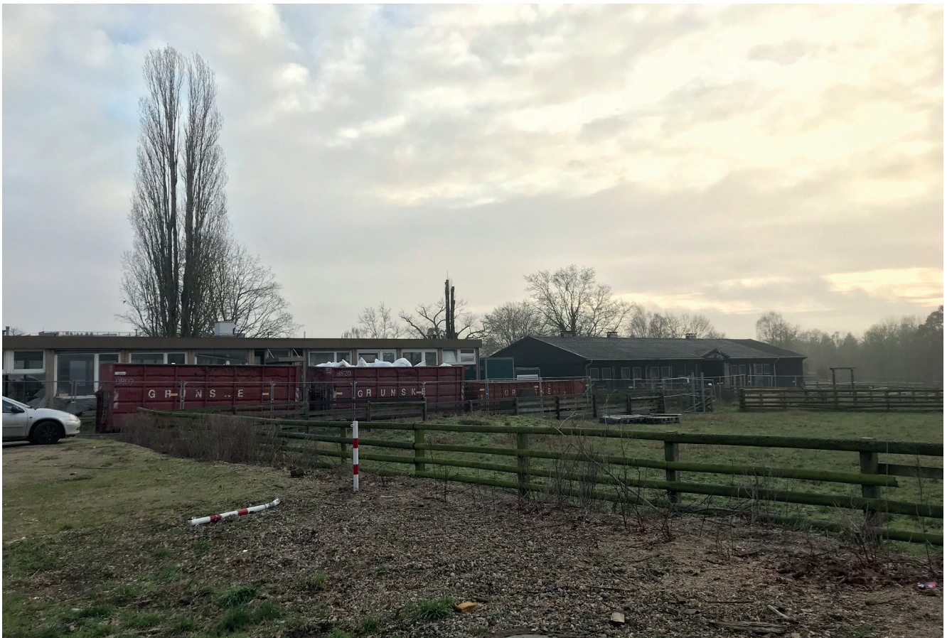
Bild 1: Blick auf die Weidefläche, den alten Kursraum der Parasitologie und den Kaltstall vor dem Beginn der Bau- bzw. Abrissarbeiten im vergangenen Jahr
