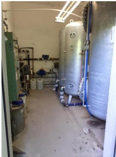
**Abbildung 1:** Filteranlage mit Brunnenpumpen (Bsp. Betrieb 6)
