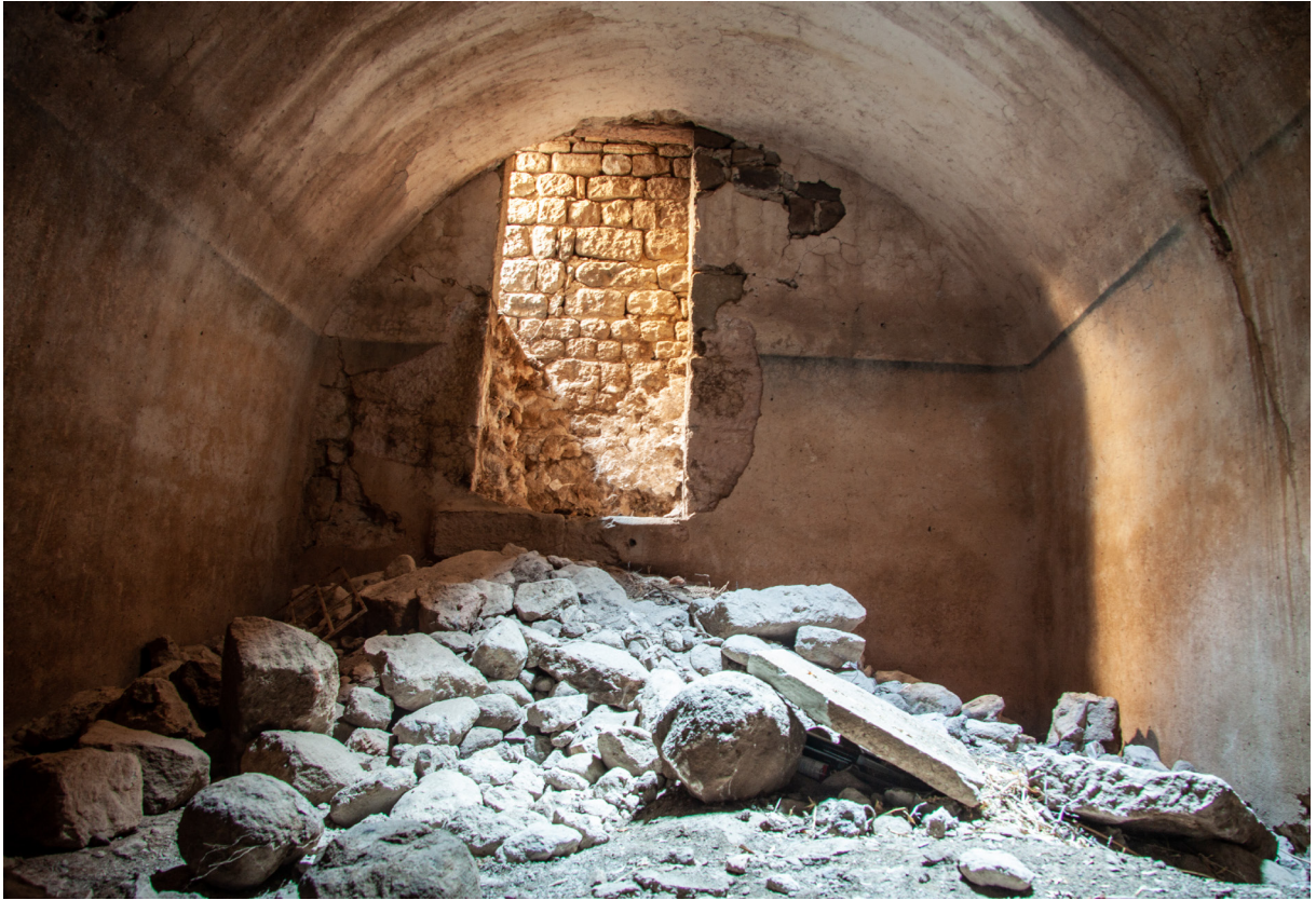
Abb. A4.5 Umland, Geyikli-Tal. Überwölbter Zisternenraum mit Zugangssituation
