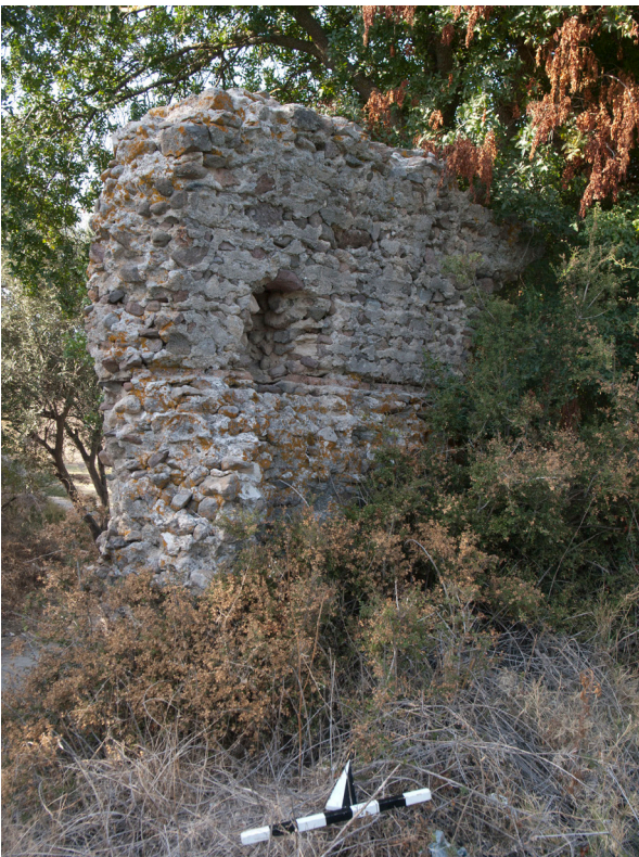
Abb. A1.3 Pergamon, Umland. Römische Baureste (Therme?) bei Sindel, Ansicht eines Mauerstücks aus Opus caementitium von Süden.
