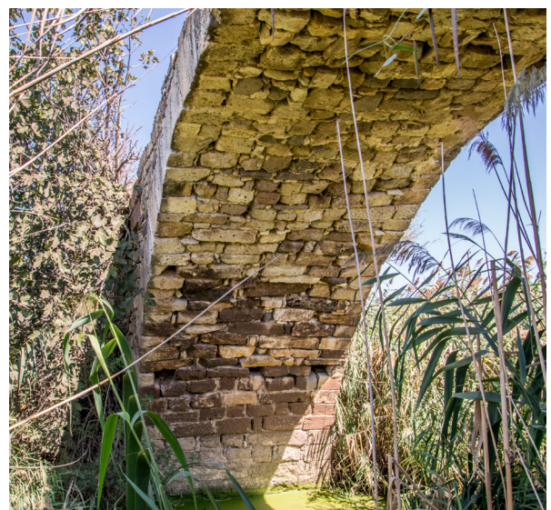
Abb. A2.14 Westliches unteres Kaikostal, Fundstelle 2018/14 – Hacismail Köprüsü. Westlicher Bogen und Mittelpfeiler der Brücke
