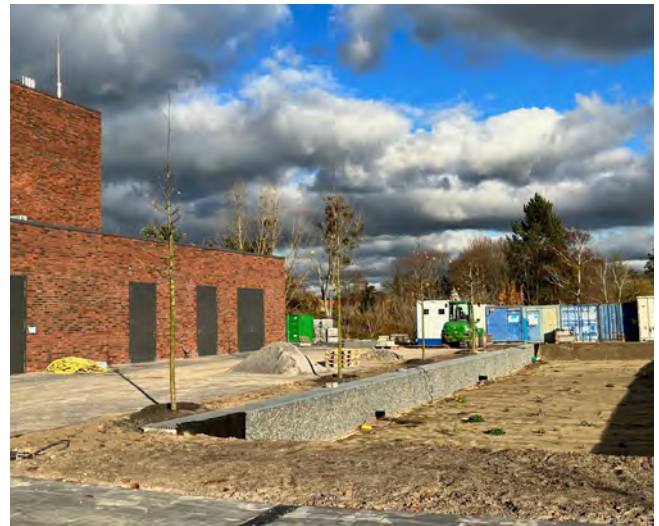
Bild 7: Außenanlagen des TZR
