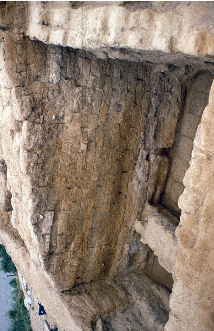
Beilage 41.1: Tall Šēḥ Ḥamad, Gebäude P, Raum E, Mauer M 25, Belüftungskanalöffnungen der oberen und unteren Reihe über Plattenboden Inst. 67 (Nutzungsphase I) von Südosten; vgl. Abb. 03.36.
