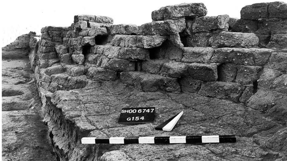
Abb. 279: In den Stoßfugen aufgerissene und auseinander gedriftete Mauerstruktur an ZM 250, der Nordmauer des Empfangsraumes.
