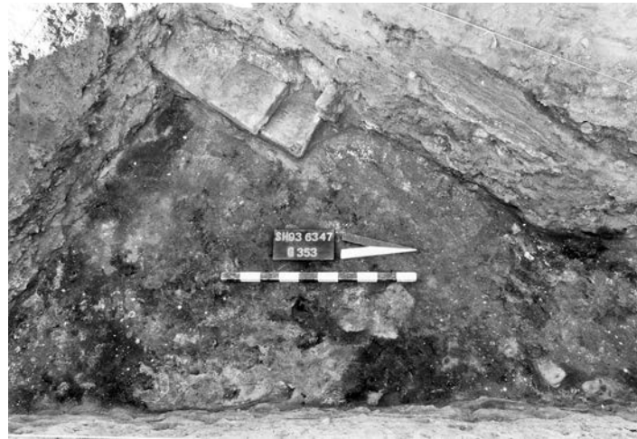
Abb. 51: Brandschutt EE FY-06-01 auf dem Fußboden in Raum FY.
