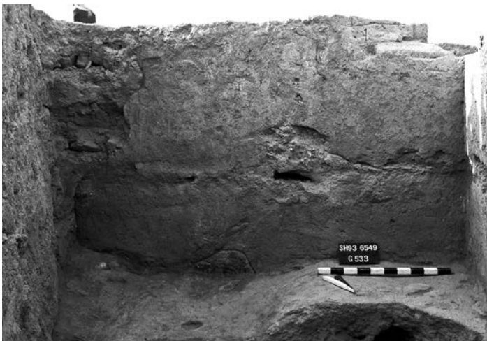
Abb. 98: Raum NZ, Fußboden I 6349/035 des Hochparterres in NZ. Die horizontale Schadstelle im Putz gibt das Niveau der Nachnutzungsbegehungsfläche I 6349/031 = 6549/372 an.
