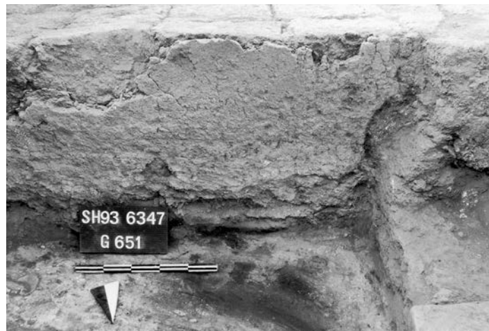
Abb. 52: Brandspuren an der Mauer und dem Wandverputz in Raum FY.
