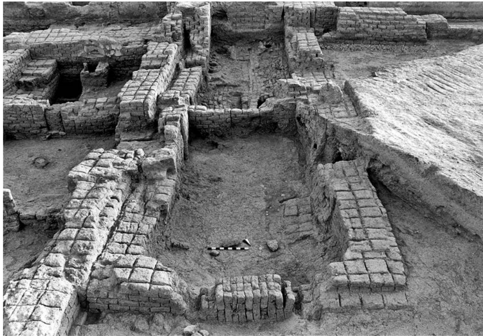
Abb. 20: Der Eingangstrakt des Roten Hauses: im Vordergrund Vestibül DY, daran anschließend Raum NZ mit den Resten der Gewölbe über den Korridoren NZ 1 und NZ 2. Die senkrecht im Zugang zu DY stehenden Ziegel stammen von verstürztem Mauerwerk.
