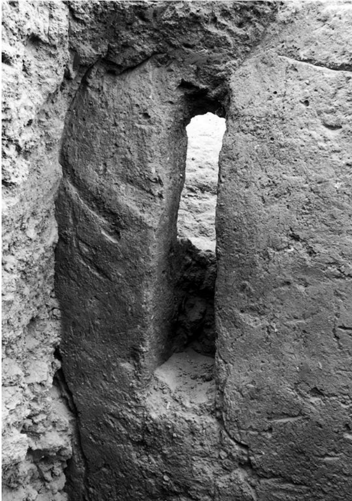
Abb. 296: 20 cm breiter und 55 cm hoher senkrechter Schlitz in ZM 211, der der Belüftung und Belichtung des Raumes IY diente.
