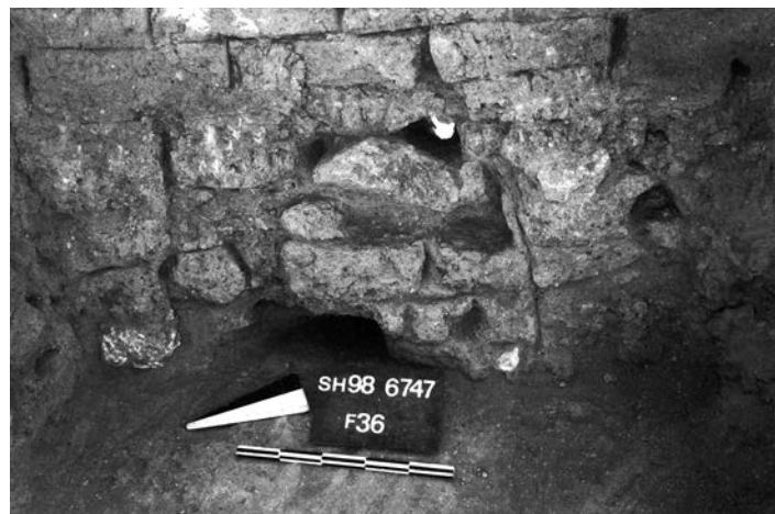
Abb. 213: ZM 305, verschlossener Mauerschaden zwischen Raum XW und Raum JU.
