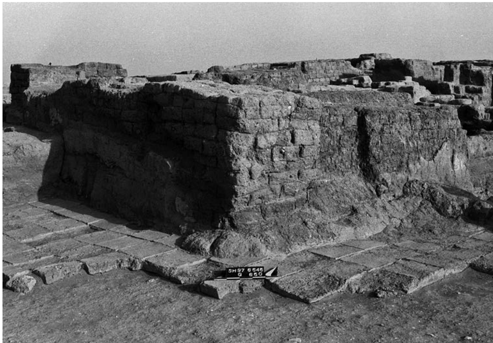
Abb. 271: Auf dem Plattenpflaster aufsitzende Stampflehmboschung in Hof TX. Gut zu erkennen ist auch die Reparatur an der Ecke der integrierten Altbaumauern ZM 243 und ZM 210 aufgrund der andersfarbigen Ziegel und dem unterschiedlichen Ziegelformat.
