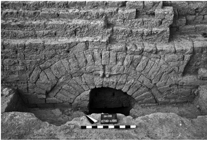
Abb. 265: Der Entlastungsbogen I 6749/049 in ZM 250. Er besteht aus zwei Wölbschalen und hat die Aufgabe, über dem aufgegebenen und verfüllten Brunnen I 6749/050 anfallende Lasten seitlich in den Boden abzuleiten.
