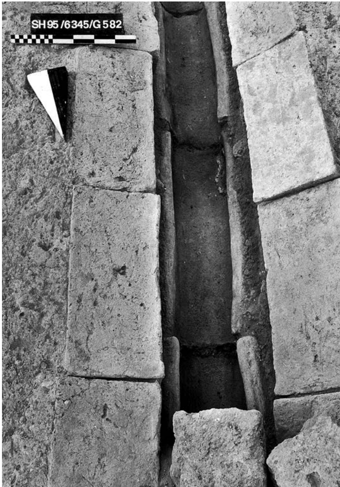
Abb. 320: In den Fußboden eingelassene und von halbformatigen, gebrannten Ziegeln flankierte Rinne aus Tonformstücken in Korridor GW.
