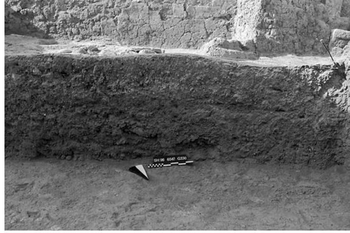
Abb. 19: Bauschutt als Substruktion des Fußbodens in Raum GY (westlicher Abschnitt): EE GY-06-01 (lockere, rötliche Lehmziegelschutterde mit Lehmziegel-Versturzbrocken) überlagert EE GY-07-01 (lockere, rötliche Lehmziegelschutterde mit wenig Asche).
