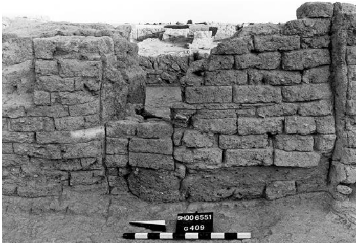
Abb. 58: Der zugemauerte Durchgang von DY nach MY verschloss den ehemaligen Haupteintrittsweg.
