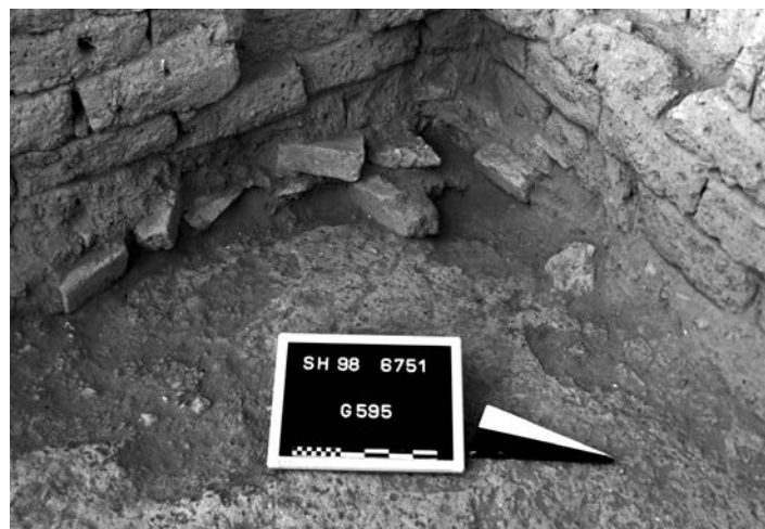
Abb. 107: Raum MU, Reparatur des Mauersockels in der Zeit der Nachnutzungen mit Fragmenten gebrannter Ziegel des ehemaligen Hofpflasters.
