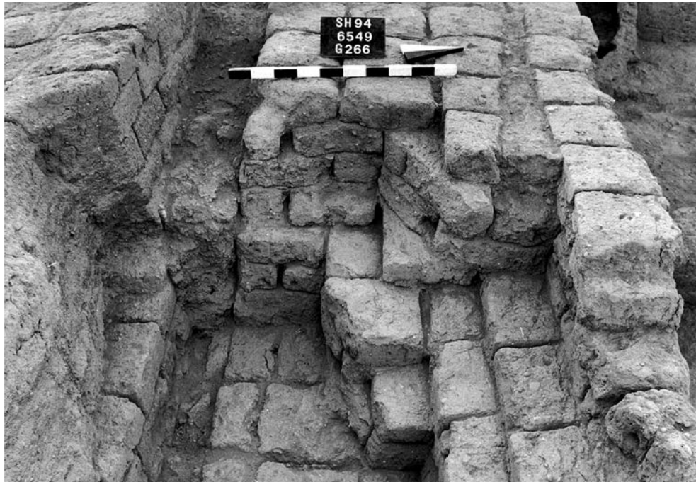
Abb. 285: Baunaht zwischen ZM 139 und ZM 197. Sie trennt gleichzeitig den West- vom Nordflügel. Wie am Fußpunkt der Mauern abzulesen ist, wurden sie absichtlich mit einem lichten Abstand von 10 cm errichtet. Da sich ZM 139 im Laufe der Zeit nach Süden geneigt hat, wuchs die Distanz zwischen den beiden Mauern an der Krone auf 40 cm an. Der Zwischenraum ist heute vollständig mit Lehmziegelschutterde gefüllt.
