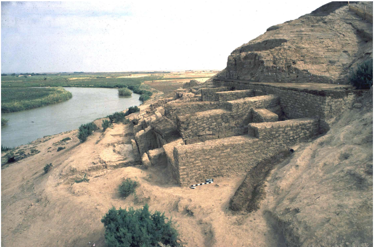
Abb. 13:03 Der Ḥabūr von Süden im Jahr 1983 mit normalem Wasserstand; im Vordergrund die im Gang befindlichen Arbeiten zur Bauwerkserhaltung am Gebäude P, Westhang der Zitadelle (Photo: H. Kühne)
