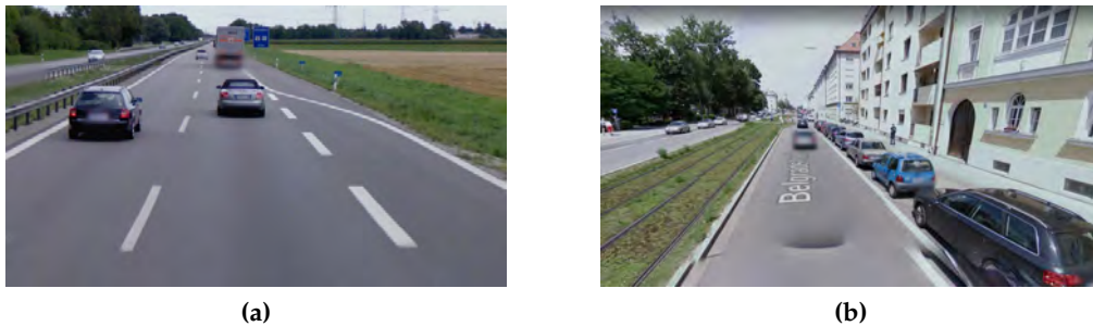
Abbildung 2.3: (a) Eine typische Autobahn in Deutschland (b) Fahrstreifenbegrenzung durch Randsteine aufgrund von Straßenbahnschienen.
