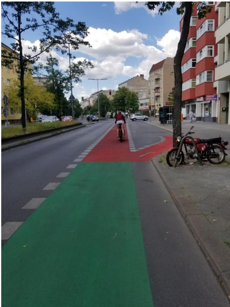
Abbildung 54: Grüner Fahrradweg in Berlin, der im Kreuzungsbereich rot wird, um auf ein erhöhtes Gefahrenpotenzial hinzuweisen (76)
