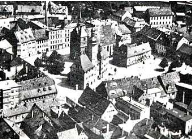
Der Marktplatz mit der Kirche, dem Rathaus und dem heutigen Stadtmuseum - eine Luftaufnahme aus den 1930 Jahren, die die auffällige Anordnung der Gebäude sichtbar macht
