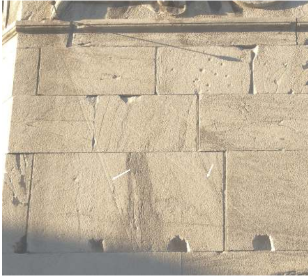
Abb. 252 i 1: Pfeile weisen auf Linienrasuren hin: an der NO-Uhr (links) und der NW-Uhr (rechts).
