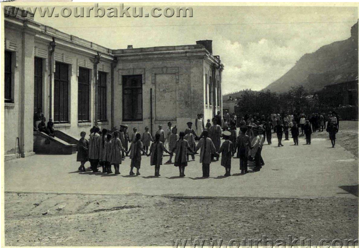
Биби-Эйбатская школа Съезда нефтепромышленников. Вид со двора. 1912 г.
