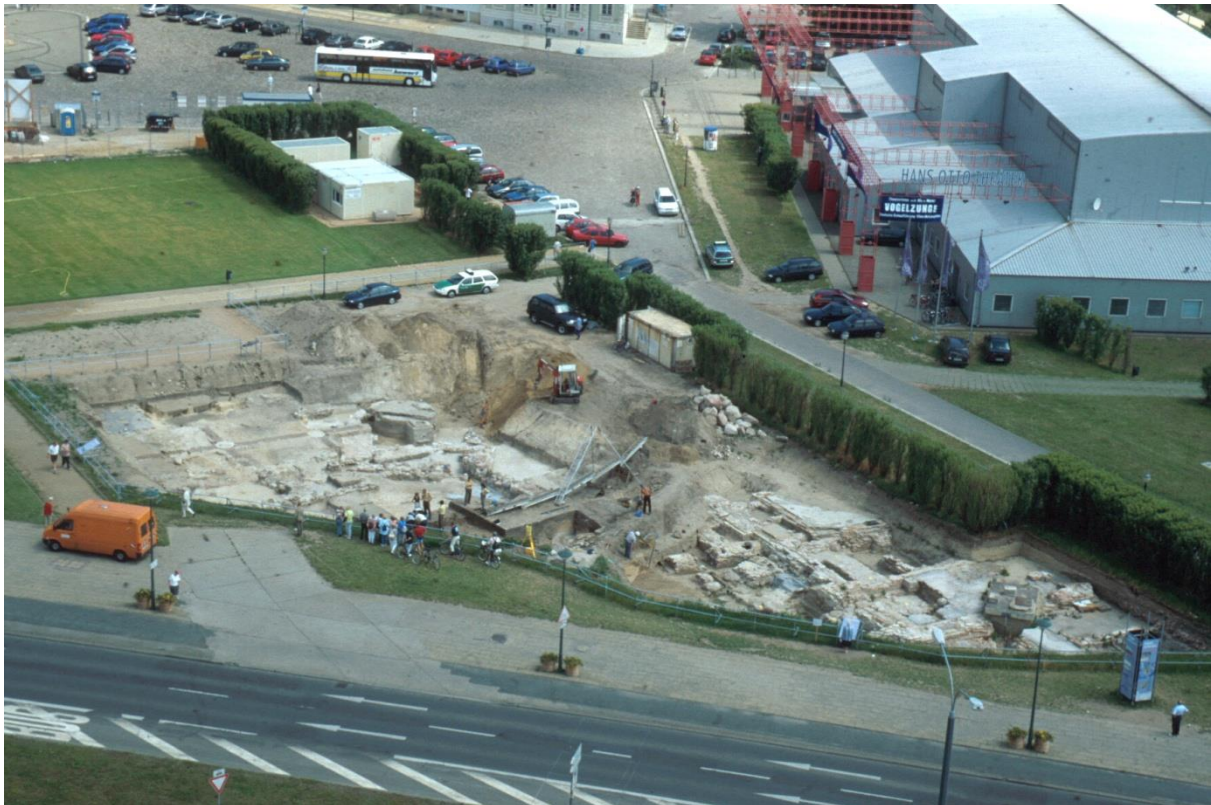
a) Übersicht über die südliche der beiden Untersuchungsflächen im Grundriss des Stadtschlusses von 2001.
