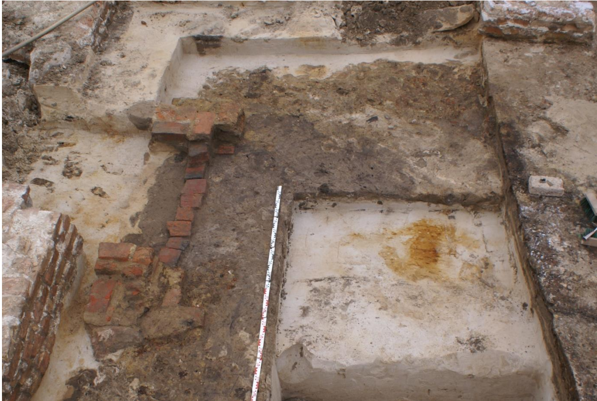
a) Eingangsbereich des Kellers 2006-4546 mit Pfeilern und Schwelle aus Backsteinen.
