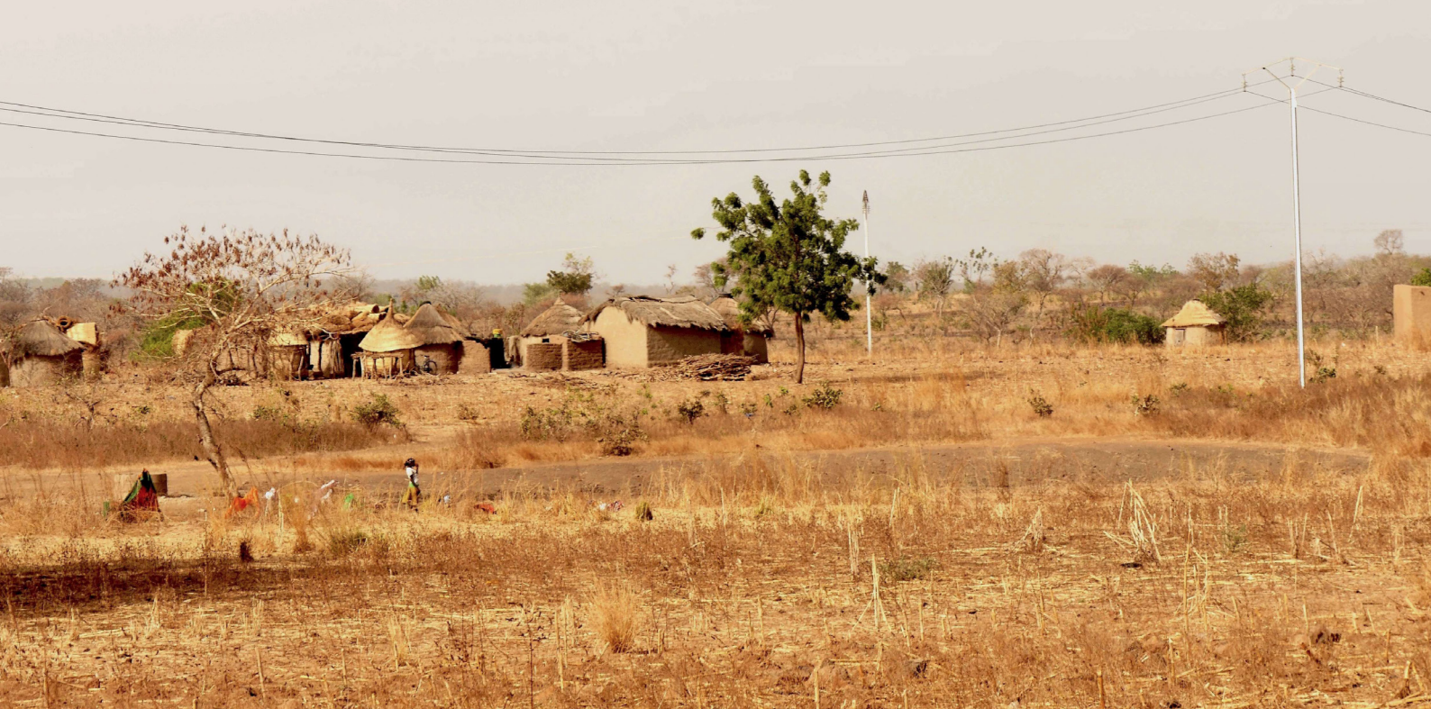
Vue depuis le village non-électrifié de Youga, sur les poteaux électriques menant à la mine de Youga (Photo: Sarah Kirst, 2017)
