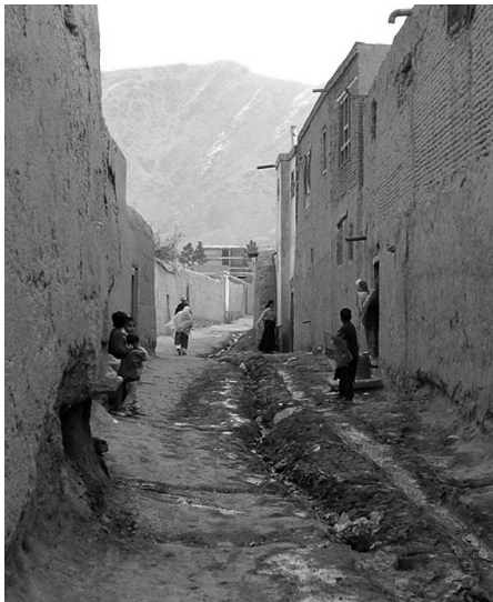
Abb. 6 Informelle Siedlung in Chehel Satun, Kabul. Abwasser wird in kleinen Entwässerungsgräben inmitten der Straße abgeleitet (Foto: Schütte 2005)
