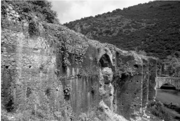
Abb. 73 Nikopolis. Blick nach Westen auf den als jünger geltenden Aquädukt im Louros-Tal bei Agios Giorgos. Im Vordergrund sind die Unterschiede im Mauerwerk erkennbar. Am rechten Bildrand sieht man die moderne Brücke über den Fluss.
