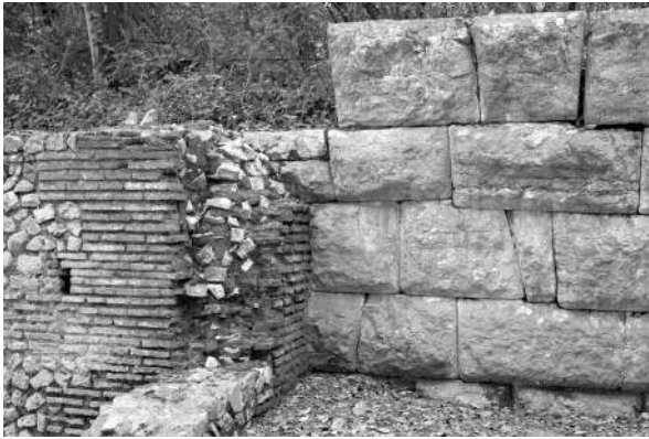
Abb. 63 Butrint. Detailansicht von Abb. 62. Das opus quasi reticulatum mit Ziegeldurchschuss ist an das Quadermauerwerk der hellenistischen Stadtmauer gesetzt.
