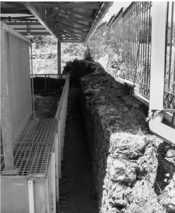
Abb. 88 Skala. Heutiger architektonischer Kontext der Mosaik. Zu sehen sind die umfangreichen Ein- und Abgrenzungsmaßnahmen, die teilweise auf den antiken Mauern errichtet sind.
