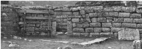
Abb. 38 Dodona. Ansicht des inneren Mauerrings im westlichen Teil des Skenengebäudes. Zustand im Sommer 2005.
