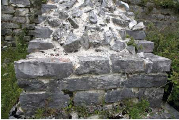
Abb. 99 Hadrianopolis. Zustand einer gereinigten und gesicherten Mauerkrone eines der Stützfeiler der cavea .
