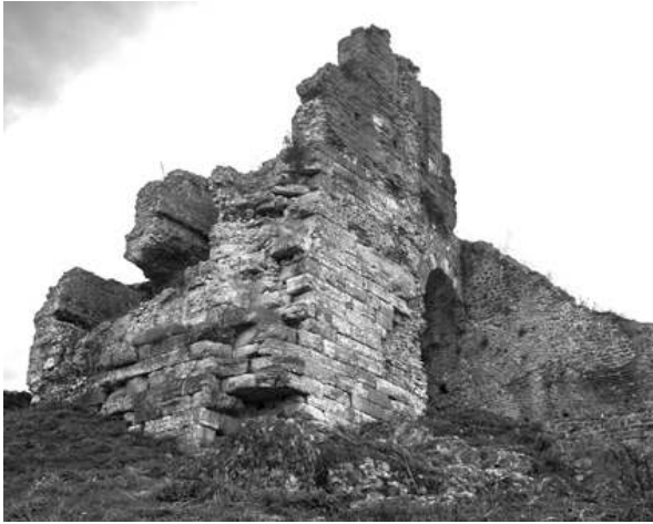
Abb. 50 Nikopolis. Ansicht der östlichen parodos . Blickrichtung Nordwesten.
