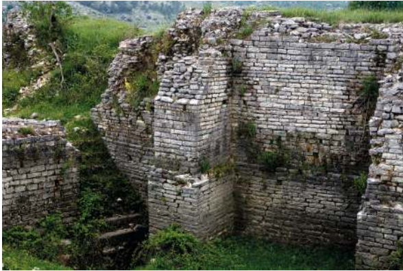
Abb. 12 Hadrianopolis. Blick auf die Stützmauer der cavea im Bereich des südlichsten Treppenaufgangs des Theaters.
