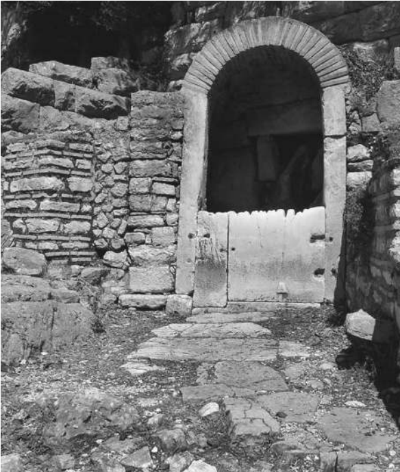
Abb. 25 Butrint. Brunnen zwischen Theater und Forum unterhalb der Akropolis.
