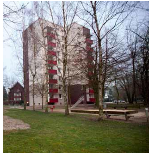
Abbildung 42: Wohngebäude Tinsdaler Heideweg - Quelle: Hamburg Energie 2015
