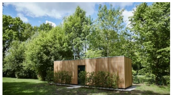
Abbildung 43: Container für Außenaufstellung des BHKWs – Quelle: KfW 2016b
