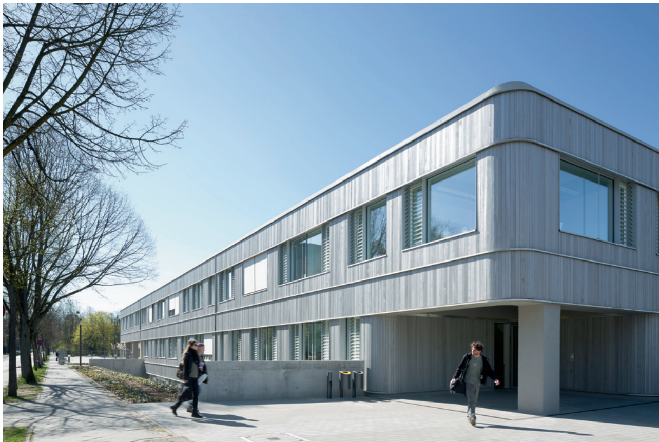
Abb. 2: Ansicht Ost der Campusbibliothek, Architektur: Florian Nagler Architekten (Foto: Stefan Müller-Naumann)
