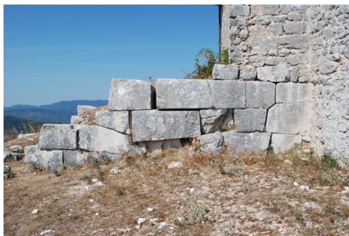
Abb. 11 | Anstoßkante Apsis und antikes Mauerwerk an der Westfassade. F. Obeloer.
