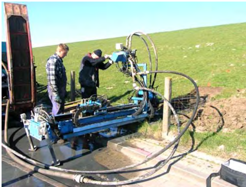
Abb. 3. Einbau der Horizontalentwässerung zur Ableitung des Wassers aus dem Deichkern.
