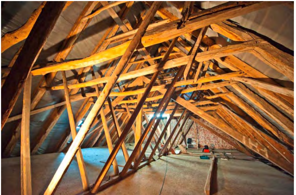
Abb. 3. Die Kirche in Schortens und ihr Dachwerk.
