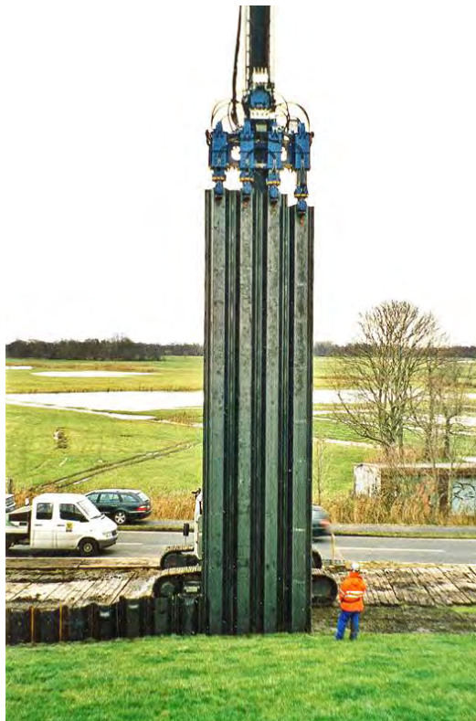
Abb. 4. Pressung der 15 bis 25 m langen Stahlspundbohlen.
