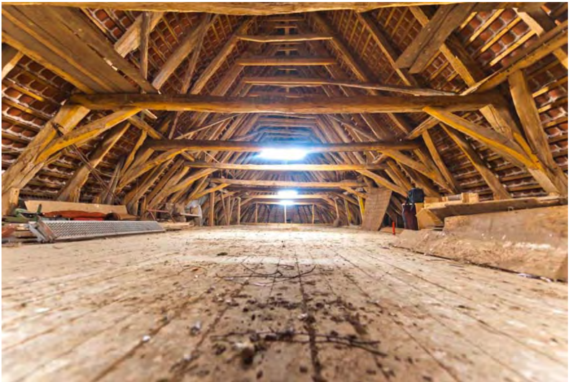
Abb. 1. Die Kirche in Reepsholt und ihr Dachwerk.
