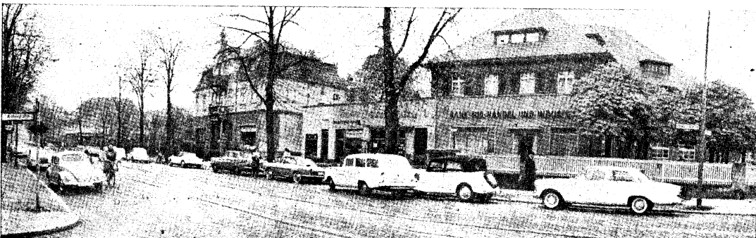
Diese Häuser in der Königin-Luise-Straße sollen verschwinden. Ein Vorort verändert sein Gesicht.
