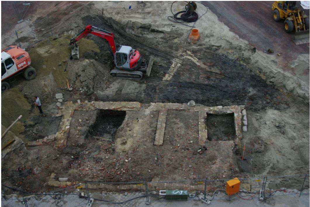
Abb. 5. Die Fundamente des Brückenturms, der den Zugang zum Oldenburger Schloss sicherte (Foto: P. Weiler, NLD).
