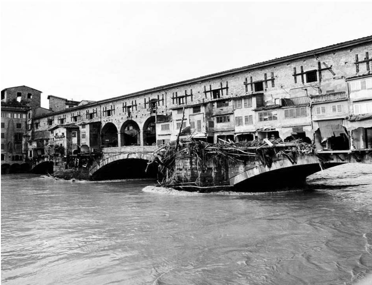
Bild 3: Die Ponte Vecchio während der Flut 1966
