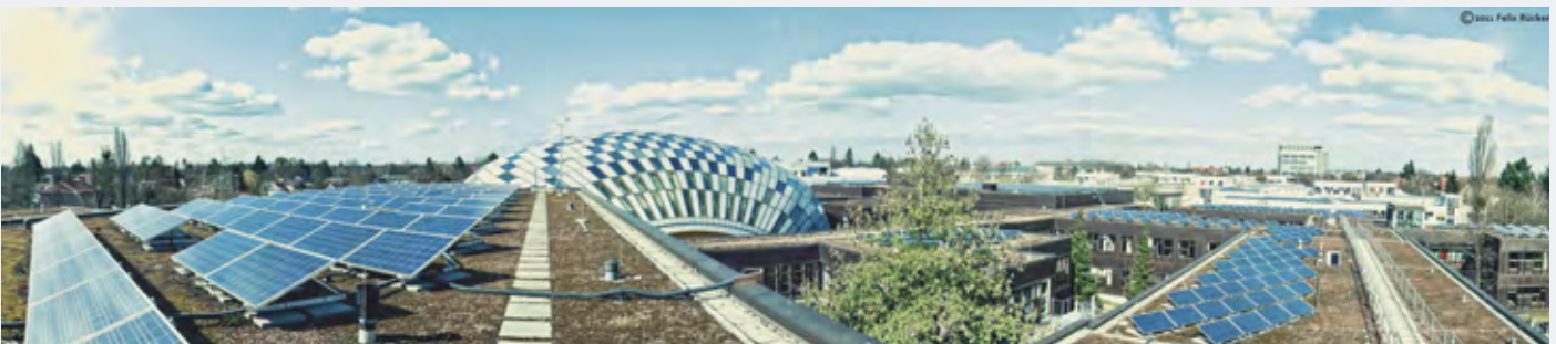
Photovoltaikanlage auf dem Dach der Rost-/Silberlaube Foto: Felix Rückert
