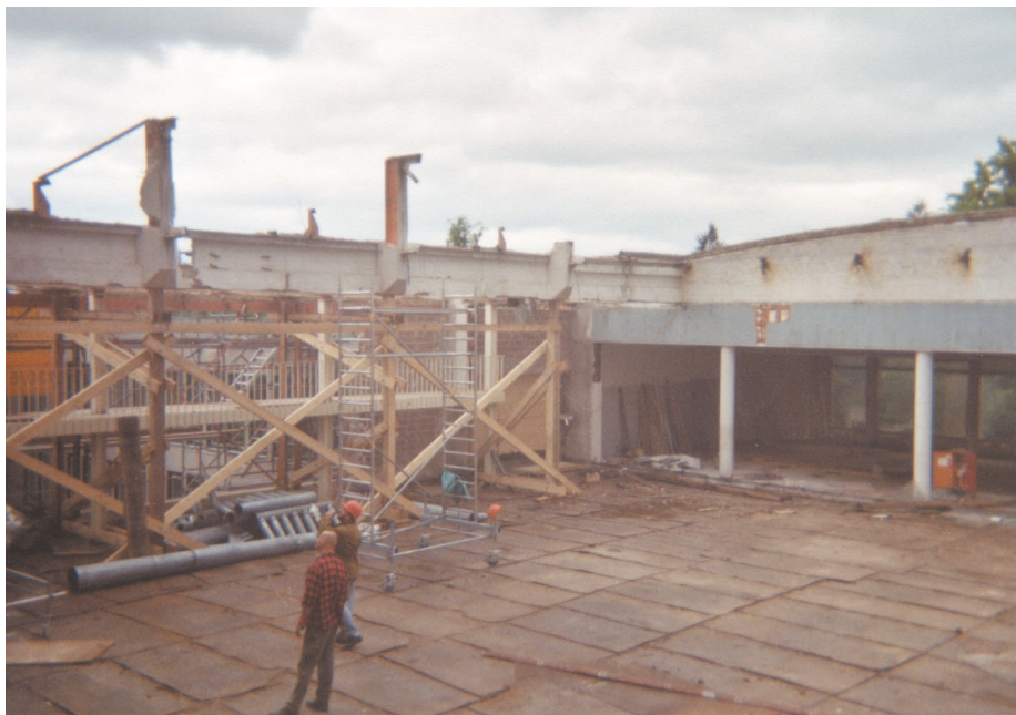
Abb. 11: Der Lesesaal nach dem Abbruch von Decke und Wänden
