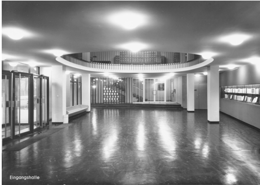
Abb. 2: Deckendurchlass zwischen Foyer und 1. Stock (1954-1970)
