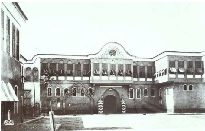
Abb. 879: Dār Wālī Kanğ Yūsuf Bāšā, ca. 1880 (Mit freundlicher Genehmigung: IRCICA)
