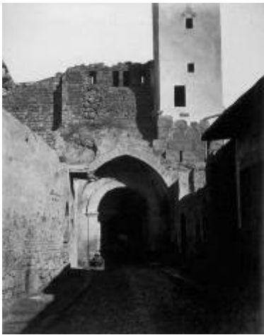
Abb. 906: Via recta am Bāb Šarqī, ca. 1880 (Mit freundlicher Genehmigung: B. El-Hage)
