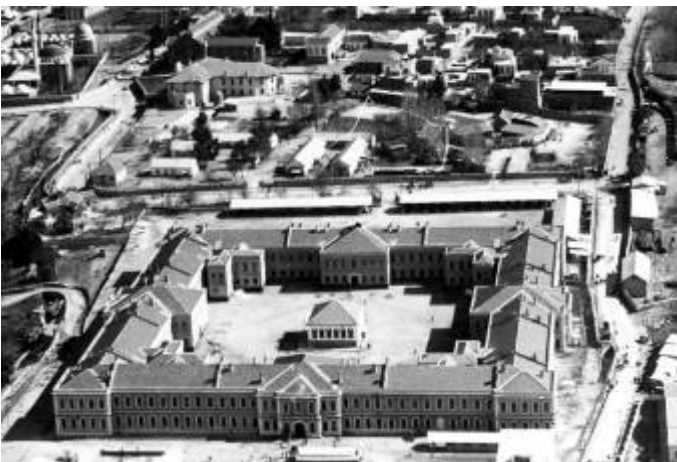
Abb. 899: Musallam-al-Bārūdī-Straße (oben), Westhälfte mit der Hamīdiyya-Kaserne [327], ca. 1930 (Mit freundlicher Genehmigung: IFPO)
