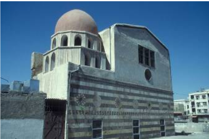
Abb. 843: Moschee aš-Šāḍbiklīya, Südfassade (Weber)
