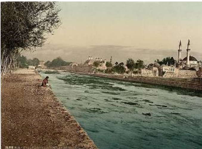
Abb. 676: Die Brücken Takīya as-Sulaymānīya (hinten) (Library of Congress)
