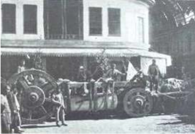
Abb. 28: Wiederaufbau der Umaiadenmoschee, Transport einer Säule vor dem Sūq al-Ḥamīdiya
