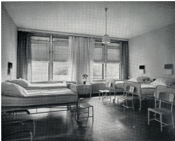
Abb. 53: Ansicht Krankenzimmer (Stoeckel 1932 S. 674)
