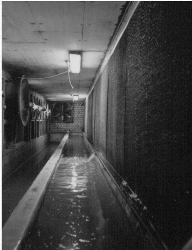
**Abbildung 2: Foto vom zweiten Cooling-Pad, Ventilatoren und Speicherbecken**
