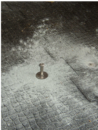
Abbildung 5: Laufflächen im Stall der Versuchstiere. Puzzleartige Verzahnung und Verankerung der Gummimatten mit Schlagschrauben.
