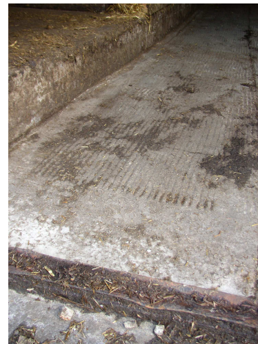
Abbildung 6: Laufflächen im Stall der Kontrolltiere. Planbefestigter Beton mit alten Fräsrillen.
