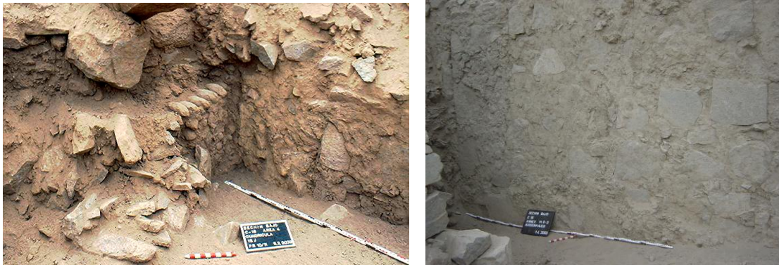
Abb. 35: Ansatz von Bau 1 an den Hauptbau. Eine dünne Baunaht zeigt die zugesetzte Treppe, oben (l.) und unten (r.).
