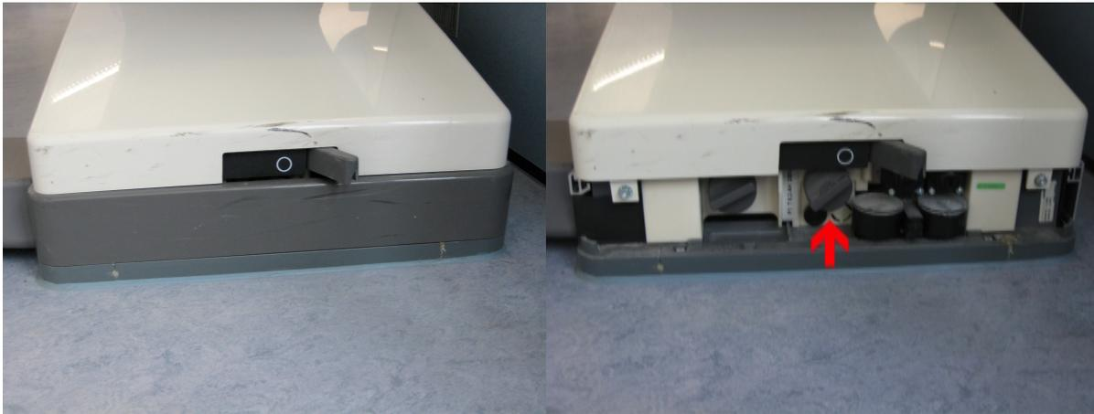
**Abb. 2-5: Verkleidung und Innenansicht der Trinkwasserentnahmestelle (siehe Pfeil) an einem Behandlungsplatz**
