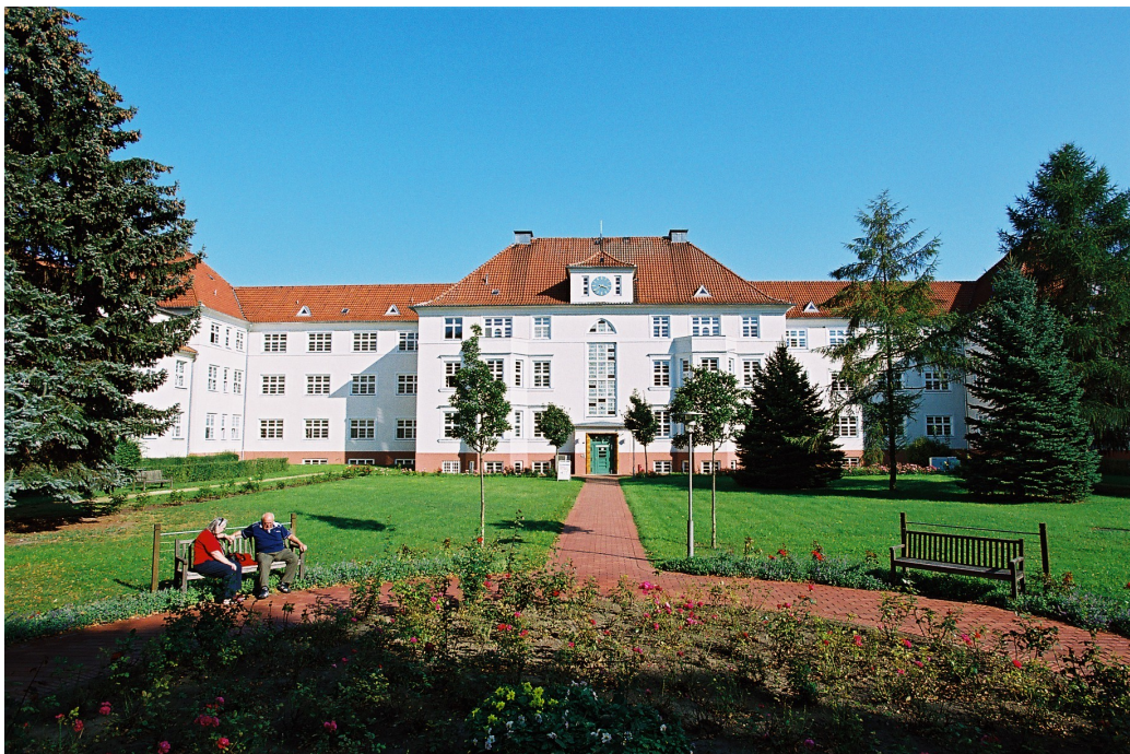
Das Kreiskrankenhaus Prenzlau.
