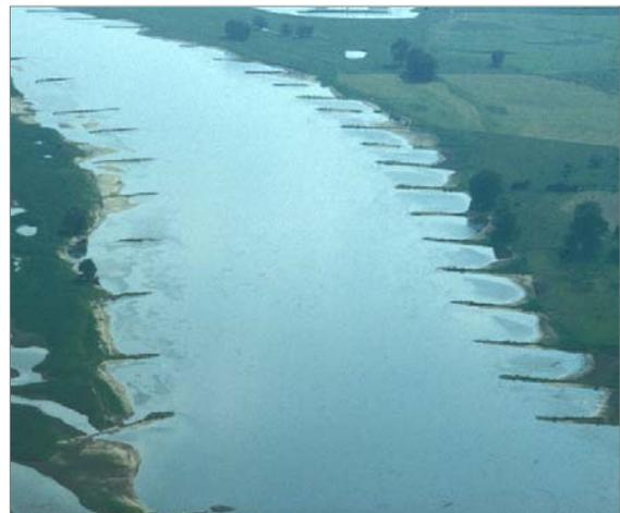
**Abb. 2-2:** Mit Buhnen regulierte untere Mittel-Elbe bei Bälöw, El-km 440, mit singulärem Flussschlauch und erheblich veränderter Morphologie, Foto: Ilona Leyer 1998
