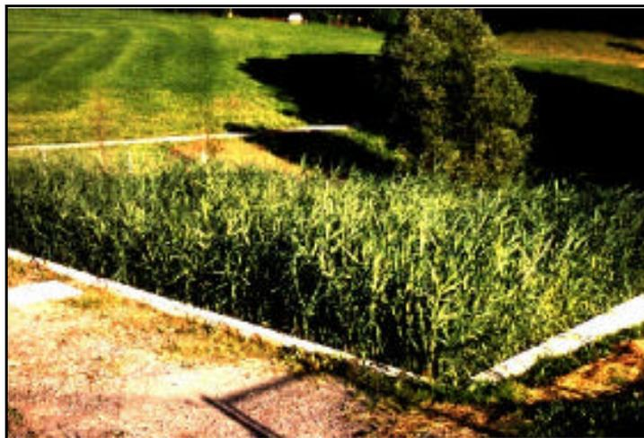
Abb. 7: Schilfbeet der Pflanzenkläranlage „Nord-1“ im Sommer mit vollem Bewuchs
