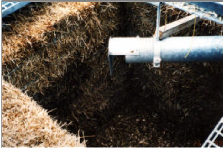
Abb. 6: Ansicht eines leeren Rottefilters, Zulauf in der Mitte, Strohballen an der Wand, Holzhäcksel als Bodenauflage
